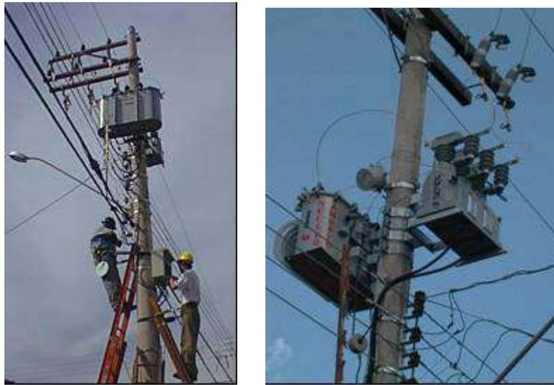
Figuras 4 e 5 - Instalação típica de transformador com equipamentos de medições na alta e baixa tensão
