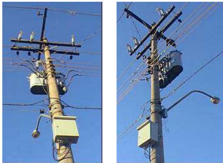
Figuras 6 e 7 - Instalação típica de transformador com equipamentos de medição na baixa tensão
